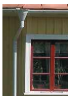
Stuprören i samma färg som listverken och äldre utformning av omfattningarna.
