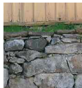
Mur kring ett av uthusen.
