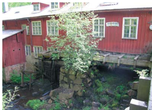
Objekt E: Vattenrännan vid Stallkvarn
