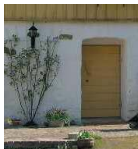
Källarvåning i sluttning.
