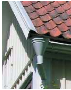
Stuprören i samma färg som listverken och äldre utformning av omfattningarna.
