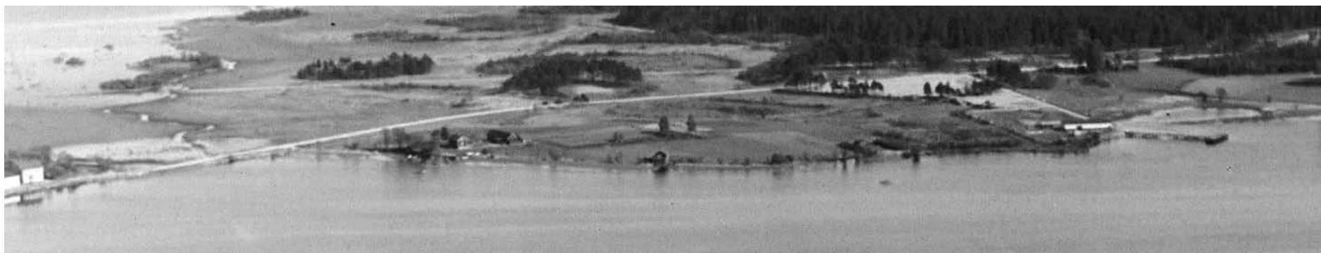
Området söder om Rocksjökanalen med de tidigare torpen Holmen och Simsholmen låg ännu i mitten av 1930-talet nästan obebyggt. Torpen omgavs av odlingsmarker och kärrmarker. Bakom dessa anlades i början av 1930-talet Jönköpings flygplats. Delförstoring av flygfoto från 1930-talets början från nordväst.
