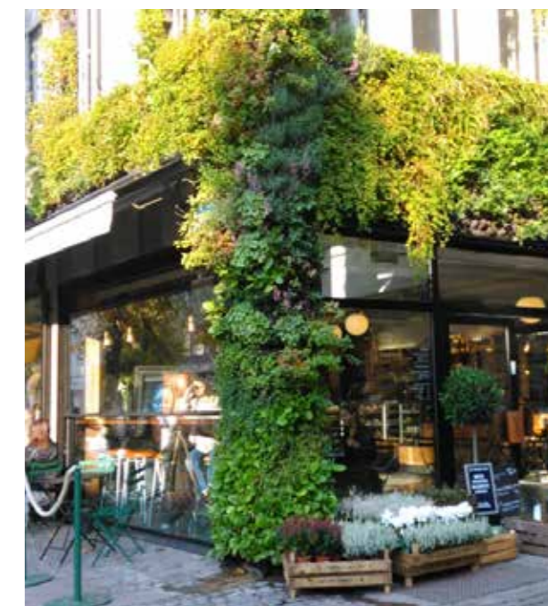
Exempel på grön vägg i Göteborg som ett positivt bidrag till stadsmiljön.
