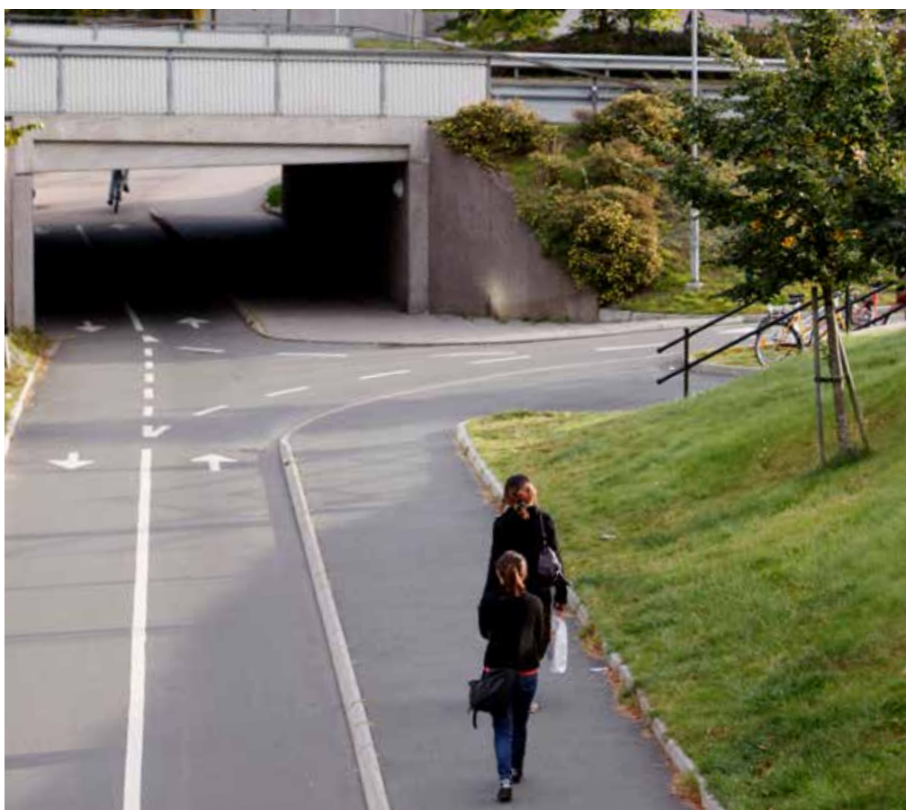
Exempel på väl separerad tunnel i Jönköping
